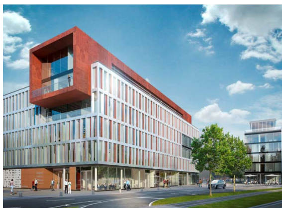
Bürogebäude Belmundo und Lavista in Düsseldorf: Baustart 2012
