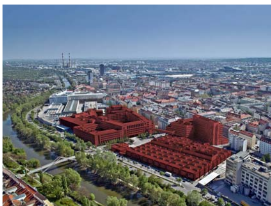
Urban development project Lände 3, Erdberger Lände
