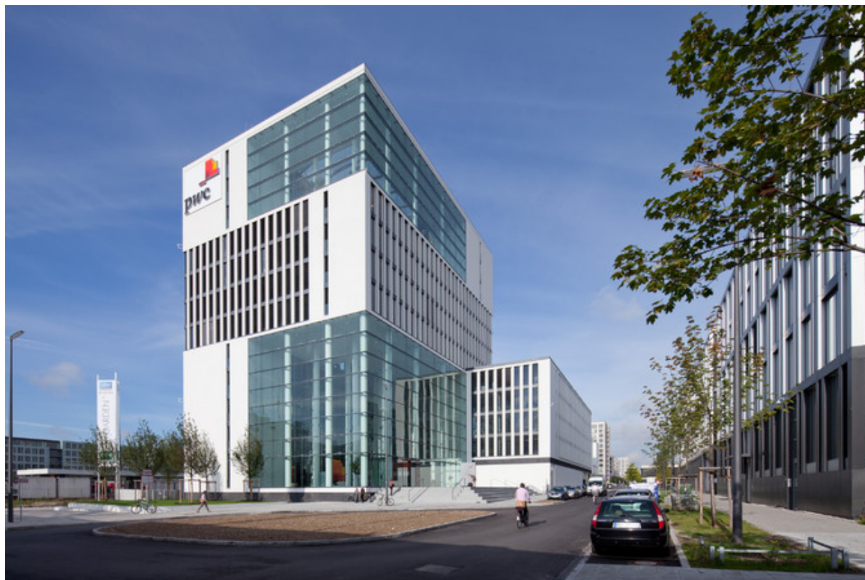
Das Bürogebäude Skygarden im Müncher Arnulfpark – aktuell zu 82 % vermietet.
