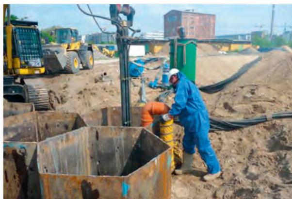
„Boden gutmachen“: Grundstücksaufbereitung durch die Bautochter omniCon in der Berliner Europacity
