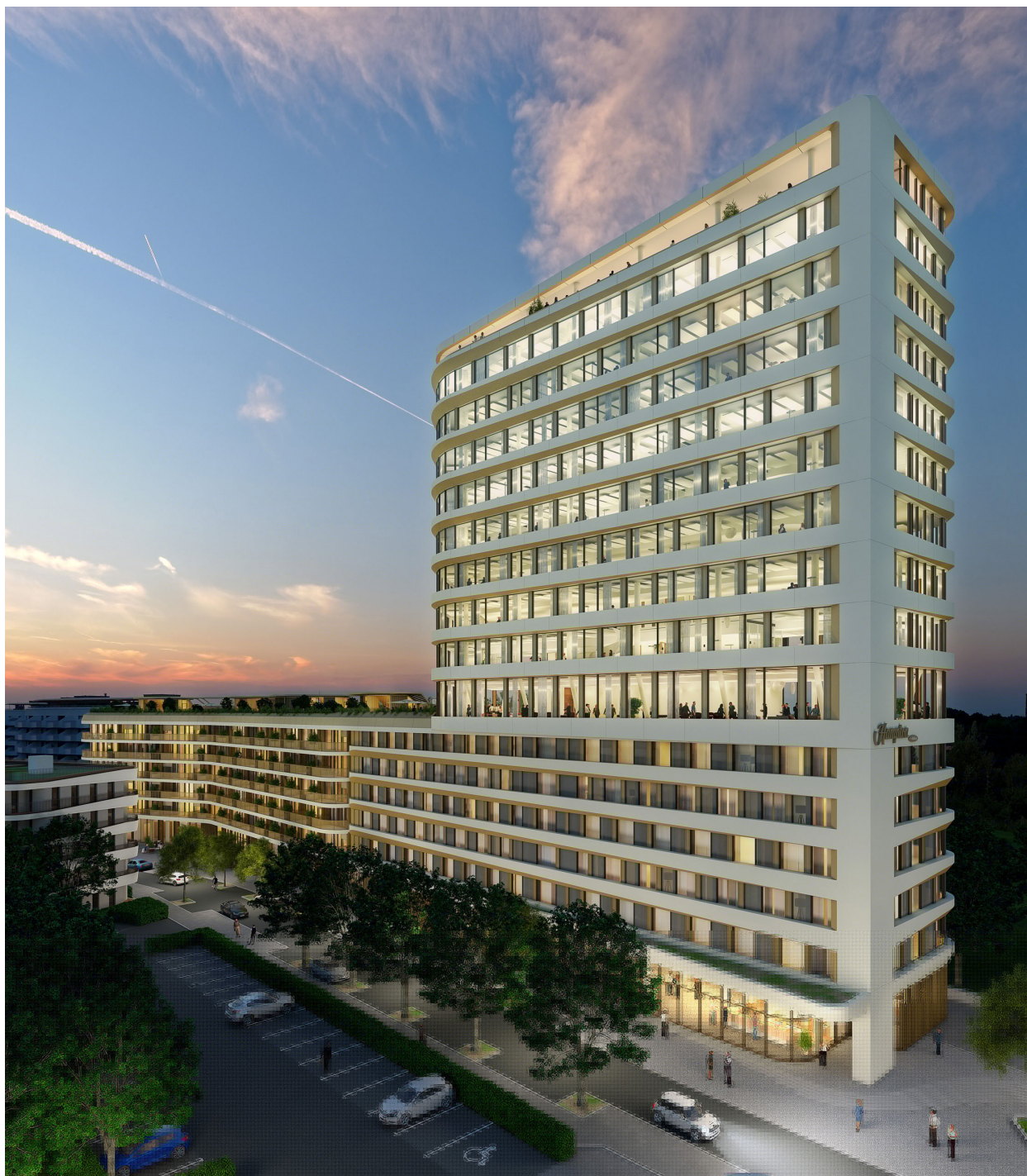
In München entwickelt CA Immo den Gebäudekomplex NEO, wofür eine DGNB Gold-Zertifizierung vorgesehen ist.
