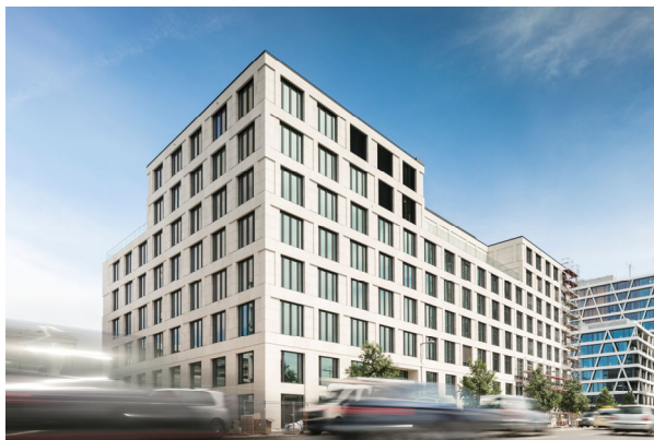
Das von CA Immo entwickelte Berliner Bürogebäude am Kunstcampus wurde im September 2019 fertig gestellt und in den Bestand übernommen.
