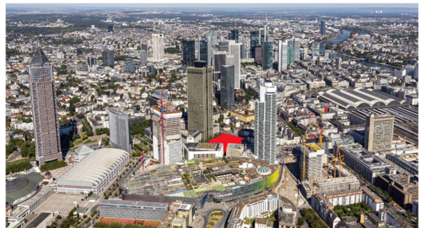
Der Architekturwettbewerb für das CA Immo-Grundstück (rot markiert) im Frankfurter Europaviertel wurde ausgelobt. Links davon: Baustelle des ONE
