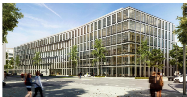
Das von CA Immo entwickelte, voll vermietete Berliner Bürogebäude MY.B wurde im 1. Quartal 2020 in den Bestand übernommen.
